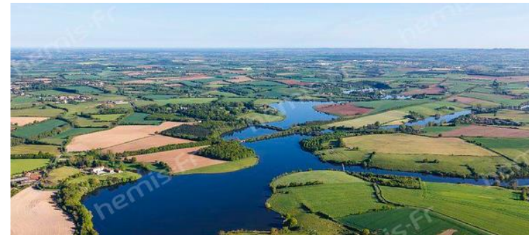
La retenue d'eau et l'usine de potabilisation du Rochereau Source photo : DG 1761669 - 06/05/2013 LEROY Francis / hemis.fr
