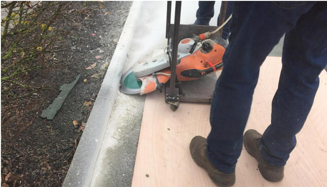
A l'aide d'une scie sur un châssis adapté, l'arasement des bordures est aisé et permettra l'infiltration de l'eau du trottoir dans les espaces verts.
