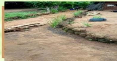
Digue de sable renforcée de plant anti-érosif: protège les cases contre l'érosion
